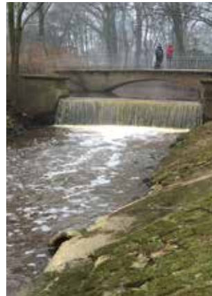
Vorher (links): Ehemaliges Wehr an der Bastaumündung. Nachher (rechts): Sohlgleite nach Rückbau des Wehres
