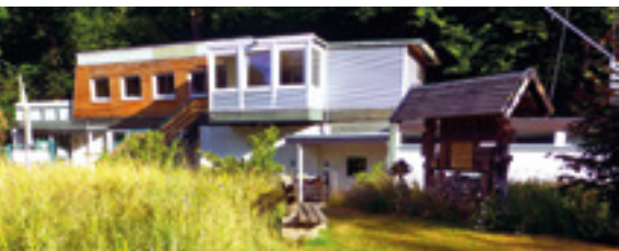
Im Gebäude des ehemaligen Freibades sind Schulungsräume, eine Küche mit Kinderküche, Büroräume und eine Holzwerkstatt entstanden.
