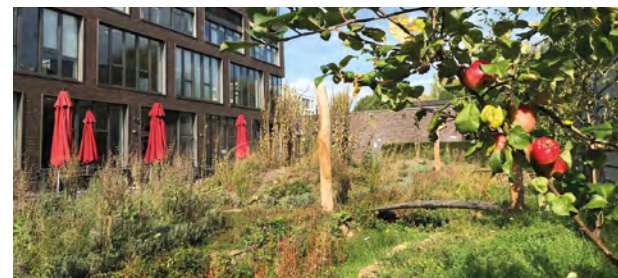
Die Retentionsmulde bei Mitsubishi Electric in Ratingen wurde als temporär wasserführender Bach Teil eines naturnah gestalteten Gartengeländes.
