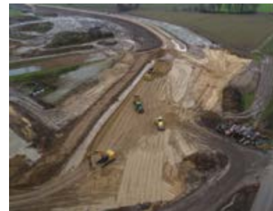
Der Bauabschnitt Nord II. Dort wird der Lippe-Deich bis zu 200 Meter weit zurück ins Hinterland verlegt, um eine 17 ha große Auenlandschaft zu schaffen.
